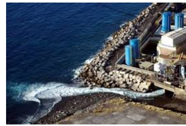
Planta desaladora de Alcudia y detalle de la evacuación de la salmuera
