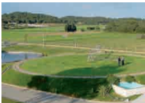
Sistema de infiltración-percolación con riego mediante un pivot con aspersores (Vall-llobrega, Girona). Fotografía: Miquel Salgot.
