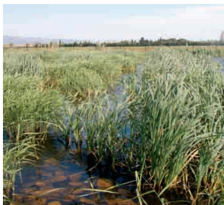
Humedal artificial de flujo libre para tratar aguas residuales urbanas (Vilajuïga, Girona). Fotografía: Antonina Torrens.
