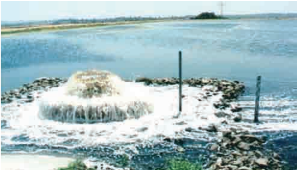
Llenado de una balsa de recarga artificial con agua regenerada procedente de una planta de tratamiento de aguas residuales de Tel-Aviv.
