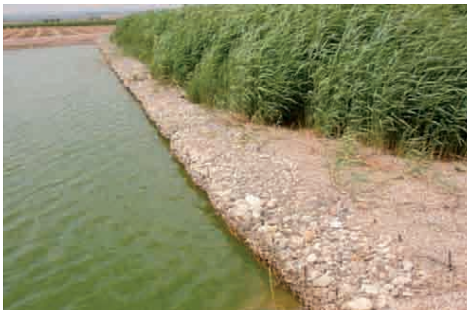
Ejemplo de combinación de tecnologías naturales (lagunaje + zonas húmedas construidas). Fotografía: Claudia Turón.
