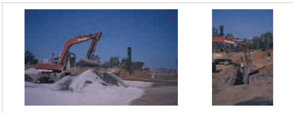
Figura 6.4.3. Construcción de una barrera reactiva para tratar el agua ácida del acuífero del río Agrio, Aználcollar, Sevilla. Se trata de la excavación de una zanja y su relleno por una mezcla de grava de caliza y materia vegetal. Se espera que al atravesar la barrera el agua aumente el pH y disminuya el pe precipitando hidroxisulfatos de Fe y Al y sulfuros de metales
