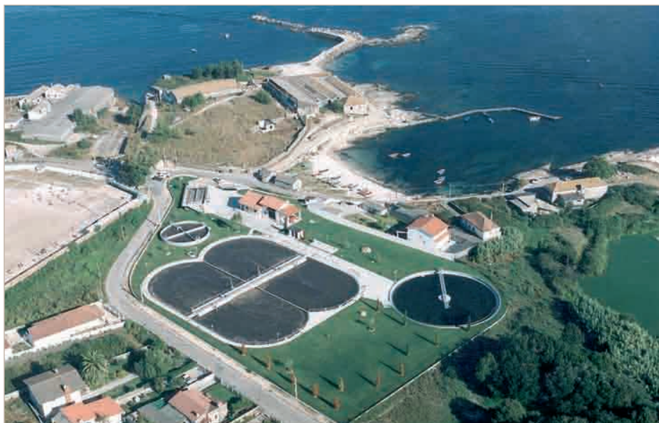
Figura 11.5.1. Estación depuradora de aguas residuales de Cangas do Morrazo (Pontevedra)
