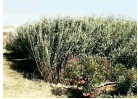
Humedal artificial de flujo subsuperficial horizontal para tratar aguas residuales de un agroturismo (Algarve, Portugal). Fotografía: Antonina Torrens.
